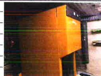
(1) **Non raccordé** (Type A) : Appareil qui n'est pas destiné à être raccordé à un conduit ou à un dispositif d'évacuation des produits de combustion vers l'extérieur du local dans lequel il est installé.
