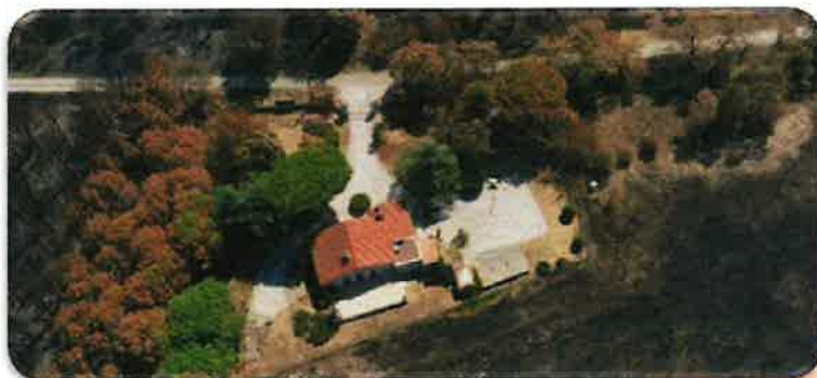
Maison débroussaillée éparpillée par le passage d'un feu - source : ONF, retravaillée
