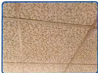
Prélèvement n° 1 : Faux plafond Plaque (dans Local commercial 1er étage Dégagement)
